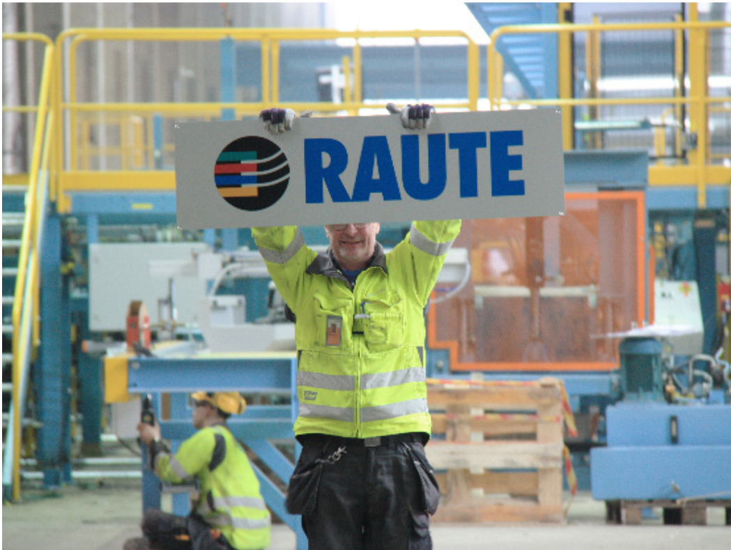
Stora Enson Varkauden LVL-tehdasprojektissa eri linjojen asennukset on pääosin saatu tehtyä.
